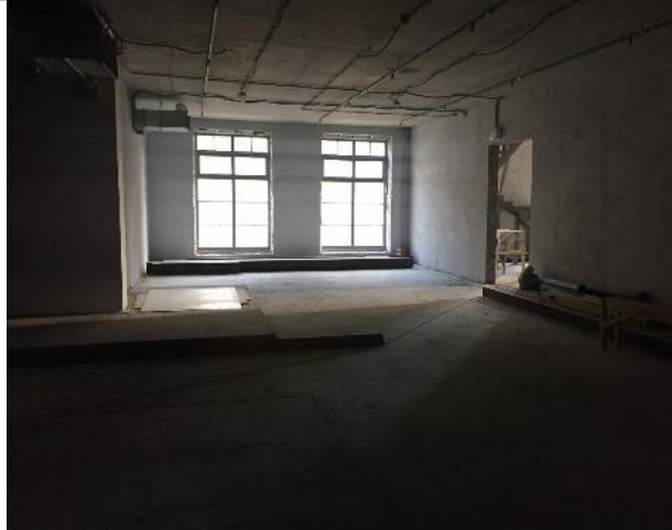
Фотография 7. Внутреннее состояние помещений
