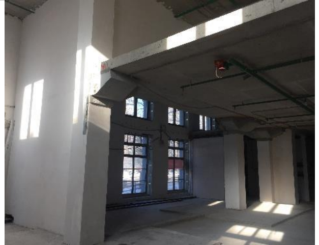
Фотография 8. Внутреннее состояние помещений
