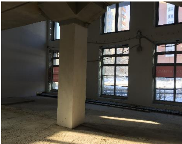
Фотография 3.3. Внутреннее состояние помещений
