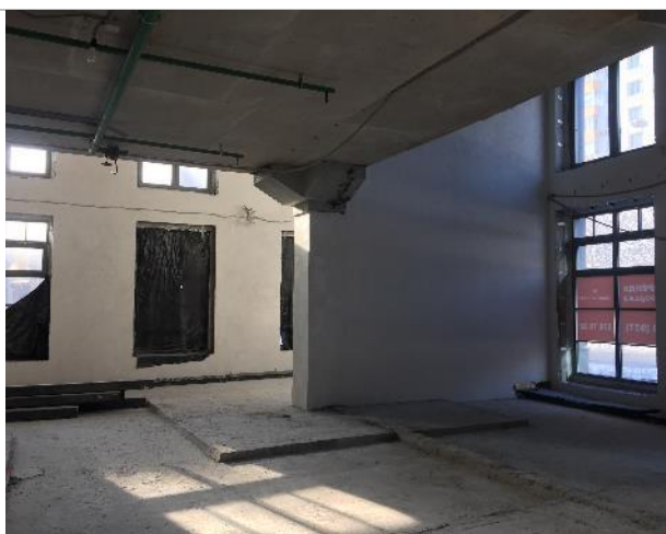
Фотография 4. Внутреннее состояние помещений
