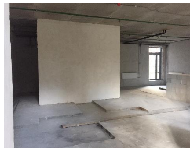
Фотография 5. Внутреннее состояние помещений
