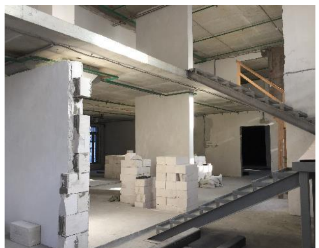
Фотография 3.6. Внутреннее состояние помещений
