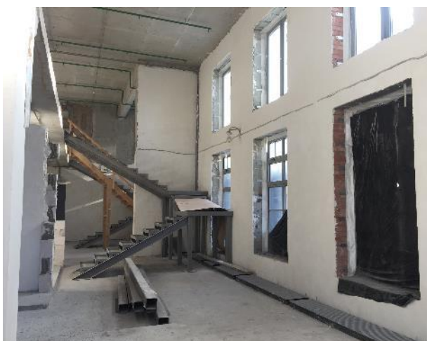
Фотография 3.5. Внутреннее состояние помещений
