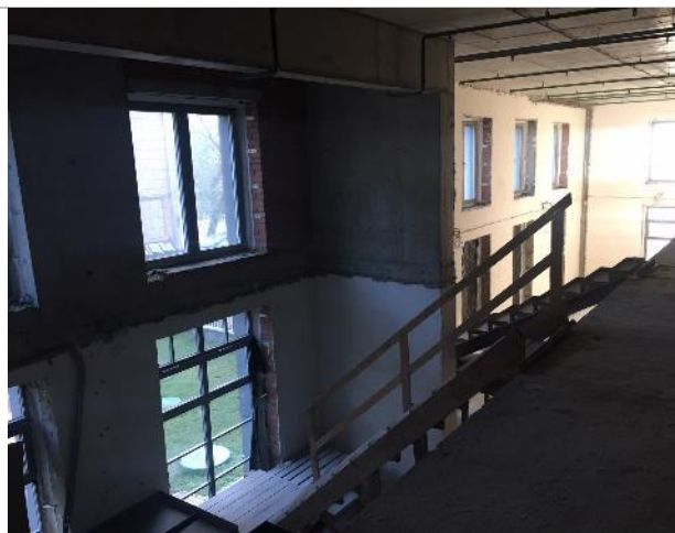
Фотография 14. Внутреннее состояние помещений
