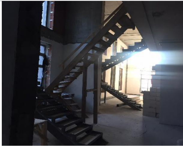
Фотография 9. Внутреннее состояние помещений
