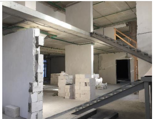
Фотография 12. Внутреннее состояние помещений
