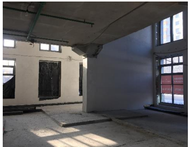
Фотография 3.4. Внутреннее состояние помещений
