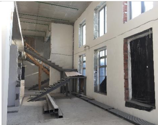
Фотография 11. Внутреннее состояние помещений
