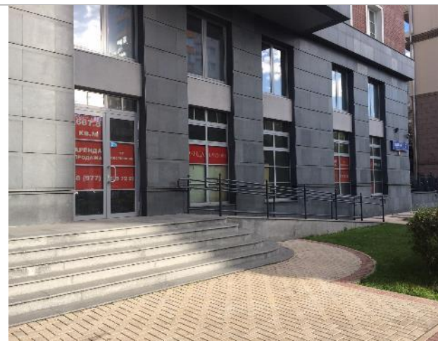
Фотография 1. Внешний вид здания
