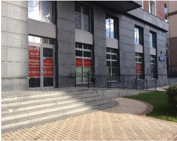
Фотография 3.1. Внешний вид здания
