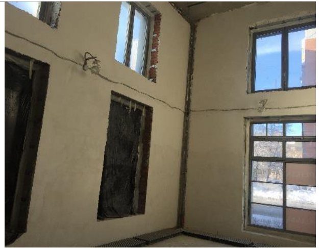
Фотография 10. Внутреннее состояние помещений
