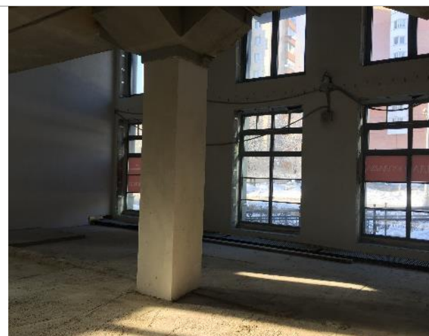
Фотография 3. Внутреннее состояние помещений
